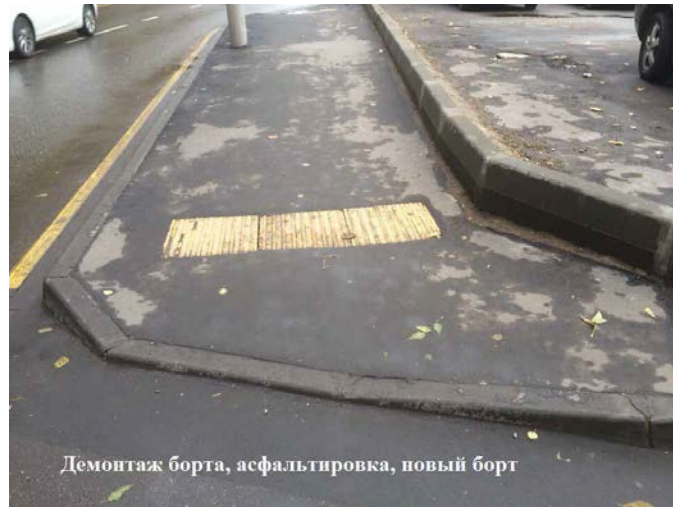
Демонтаж борта, асфальтировка, новый борт
